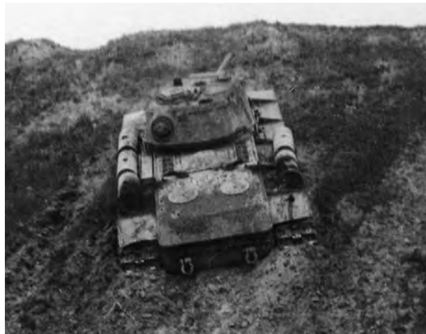
Танк КВ-1С выпуска апреля 1943 года во время испытаний на гарантийный километраж. Машина преодолевает подъем в 33 градуса. Май 1943 года.
